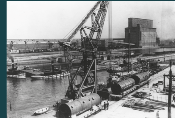
Trois chaudières de vingt-cinq tonnes déchargées du vapeur Manchester Engineer, port de Montréal, 1910. Musée McCord d'histoire canadienne (MP-1979.155.231) / Three 25-ton boilers landed from S. S. Manchester Engineer, Montreal harbour, 1910. McCord Museum of Canadian History (MP-1979.155.231)
